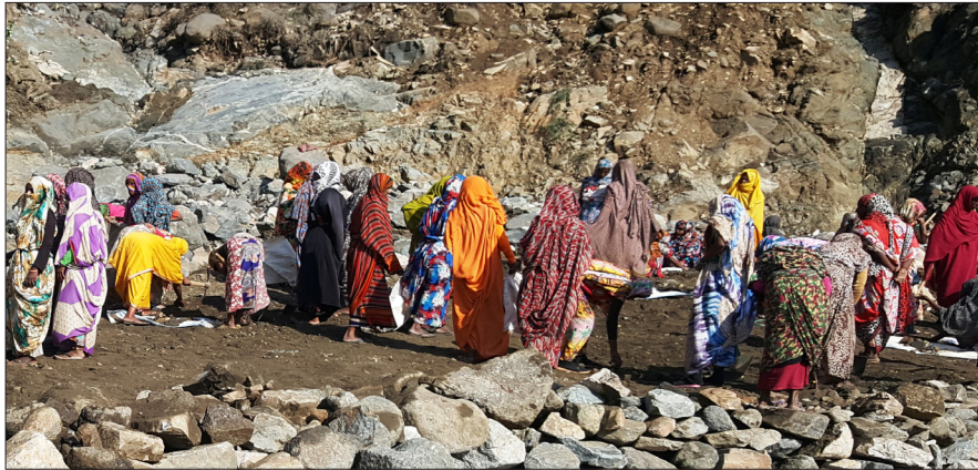
ደቀንስትዮ ናቕፋ ኣብ ምዝርጋሕ መስመር ማይ
